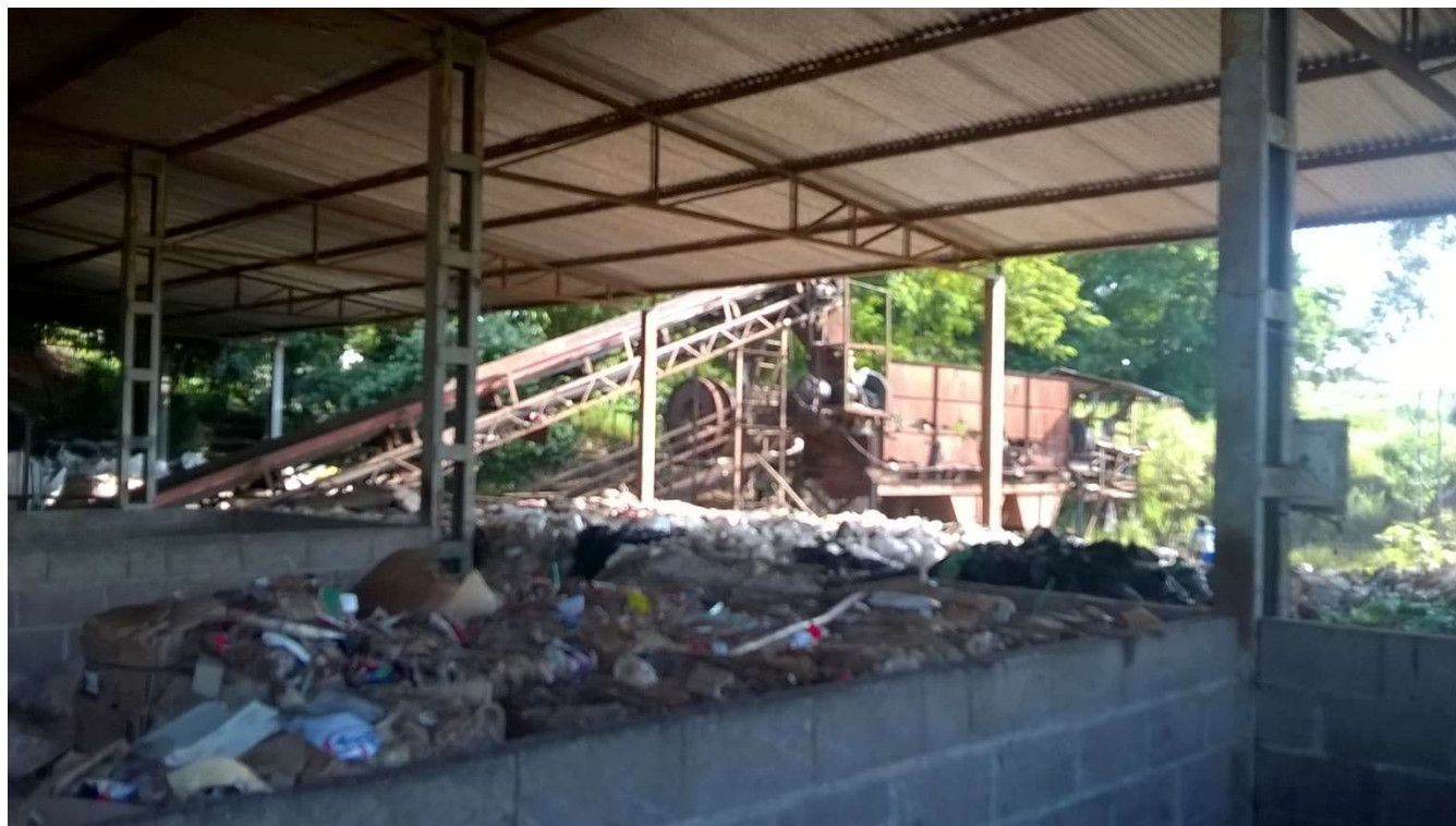
Foto 4 – Apresenta baias para armazenagem dos materiais e esteira de transporte dos resíduos.
